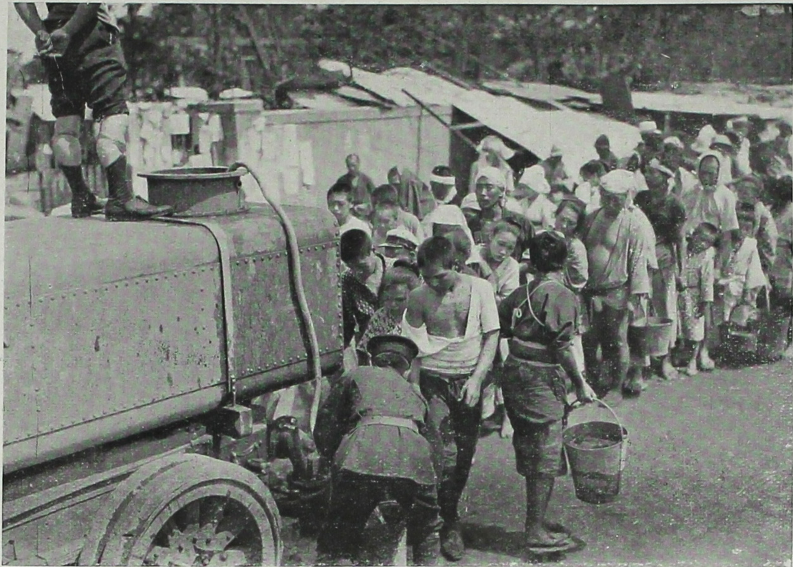
飲料水の配給を待つ罹災者（深川区伊勢崎町附近）
