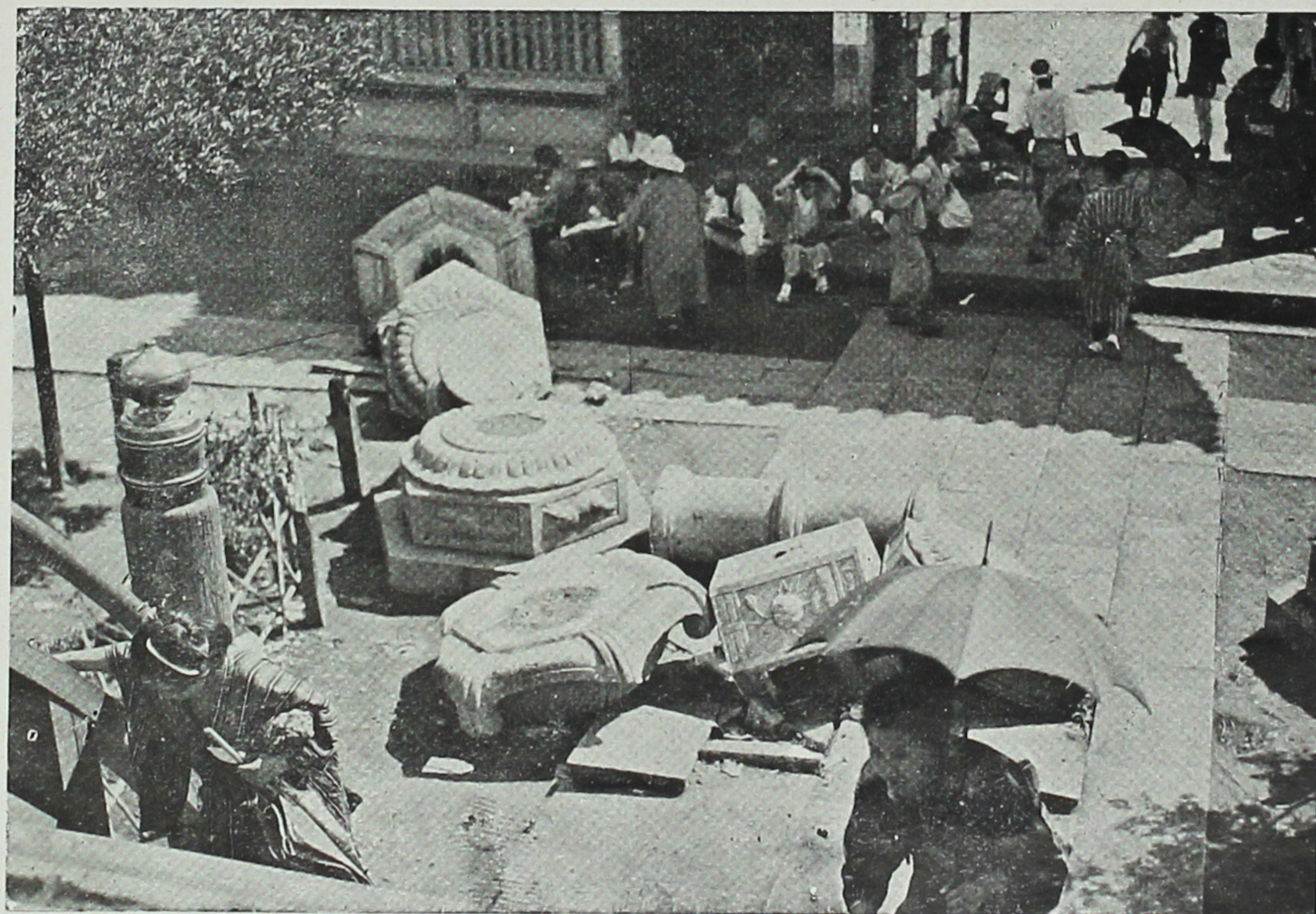
倒壊した龜井戸天神境内の石燈籠
