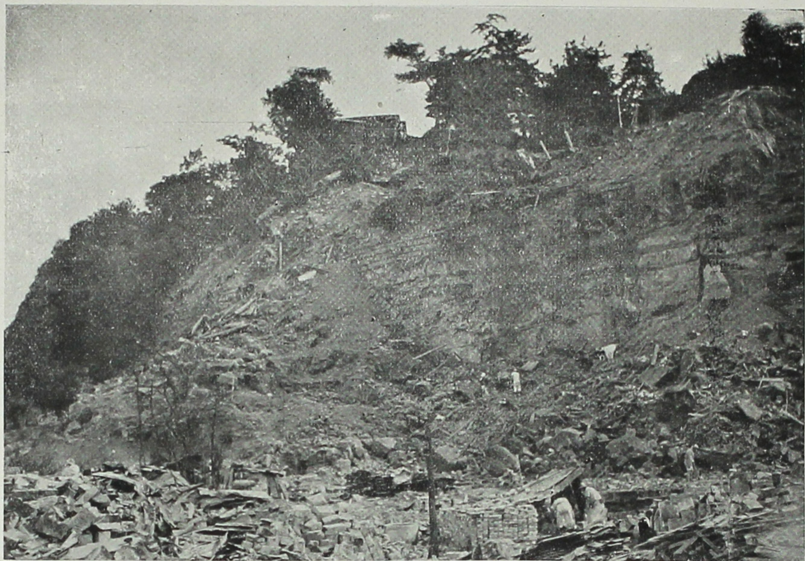
山崩れの爲め埋没した横須賀市街の一部
