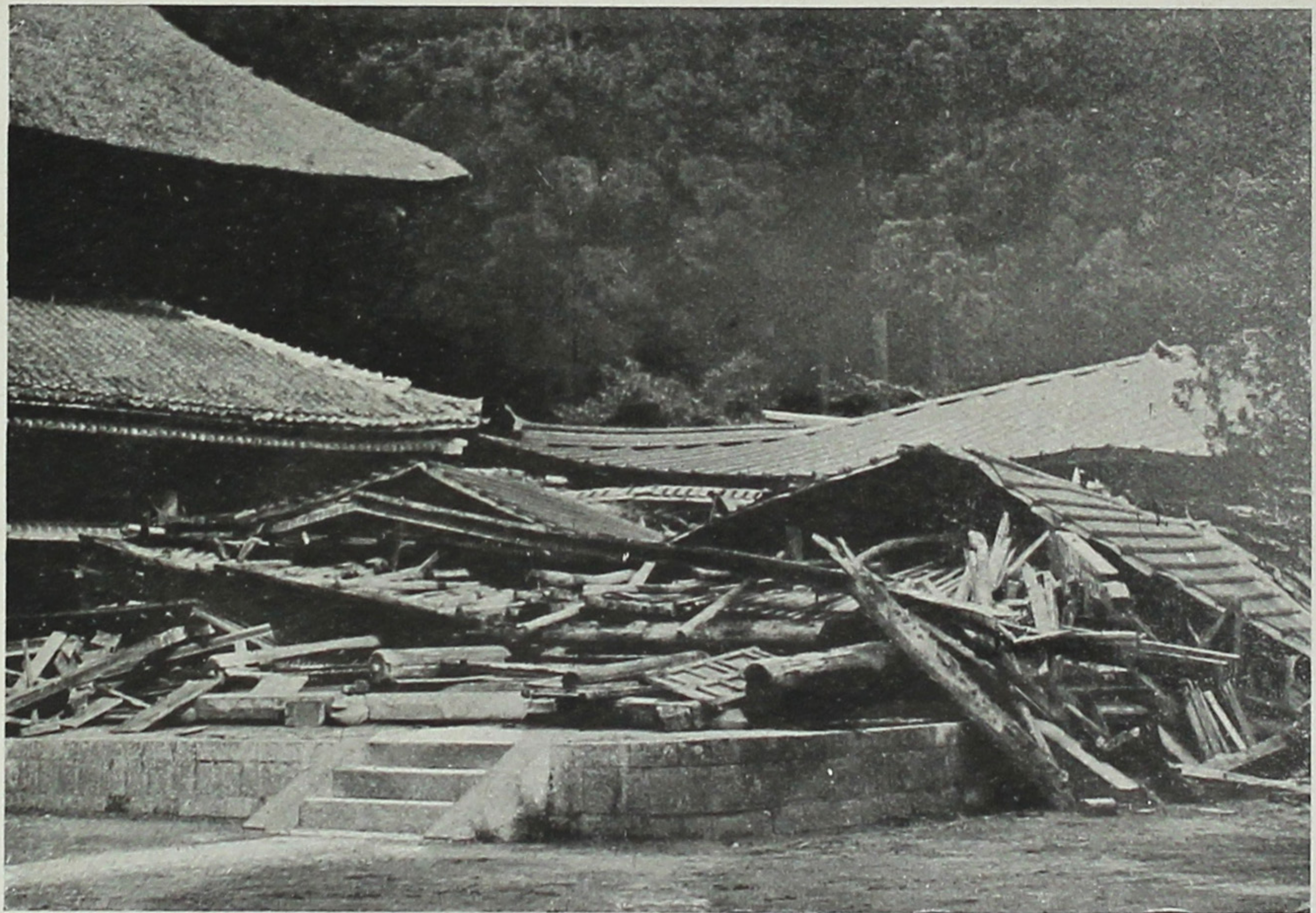
倒壊した建長寺 (鎌倉)
