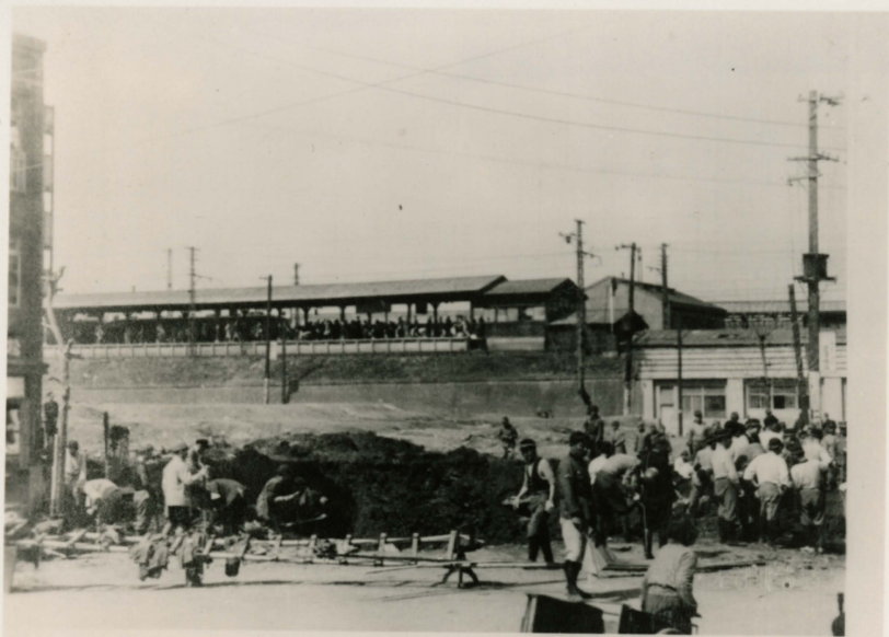
高島川沿線の建設現場（昭和十一年）
