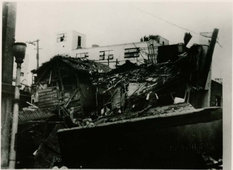
昭和十一年一月一日 此處為池邊波源場 當時有屋宇倒塌
